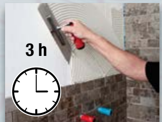
bardzo szybki postęp prac
