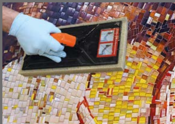
Bardzo łatwe zmywanie bez pozostawiania zacieków – z pomocą wspomagającego mycie środka PCI Durapox® Finish.
