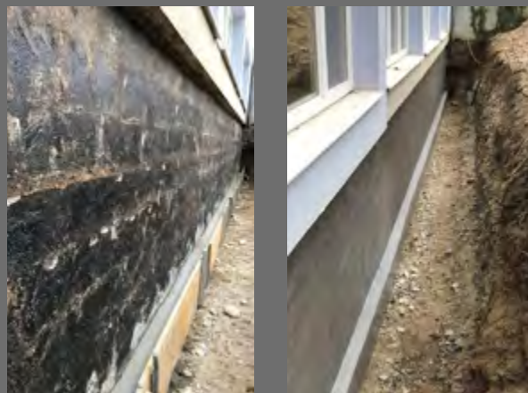
PCI Barraseal® Turbo umożliwia odtworzenie hydroizolacji pionowej na istniejących powłokach bitumicznych.
