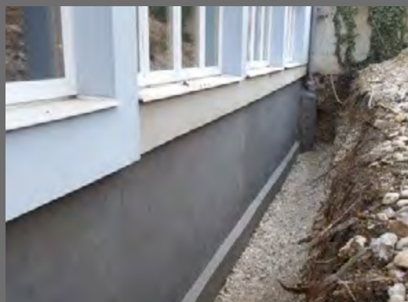
PCI Barraseal® Turbo umożliwia szybki postęp prac – po 4 godzinach od aplikacji powłoka jest odporna na deszcz, a w przypadku ścian fundamentowych po 6 godzinach można zasypać wykop.
