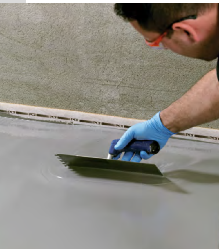
Fot. 3. Wylewka PCI Pericem® 515 doskonale nadaje się do szybkiego i bardzo dokładnego wyrównania posadzki
