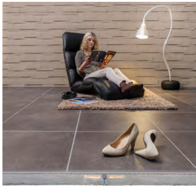
Fot. 8. Efekt przeniesienia dylatacji podłoża
