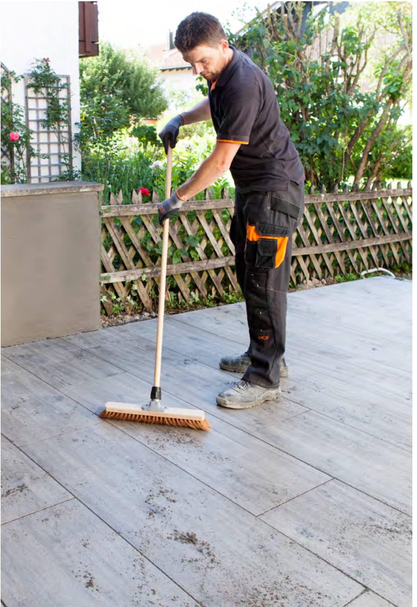
Fot. 10. Taras z okładziną wielkoformatową.
