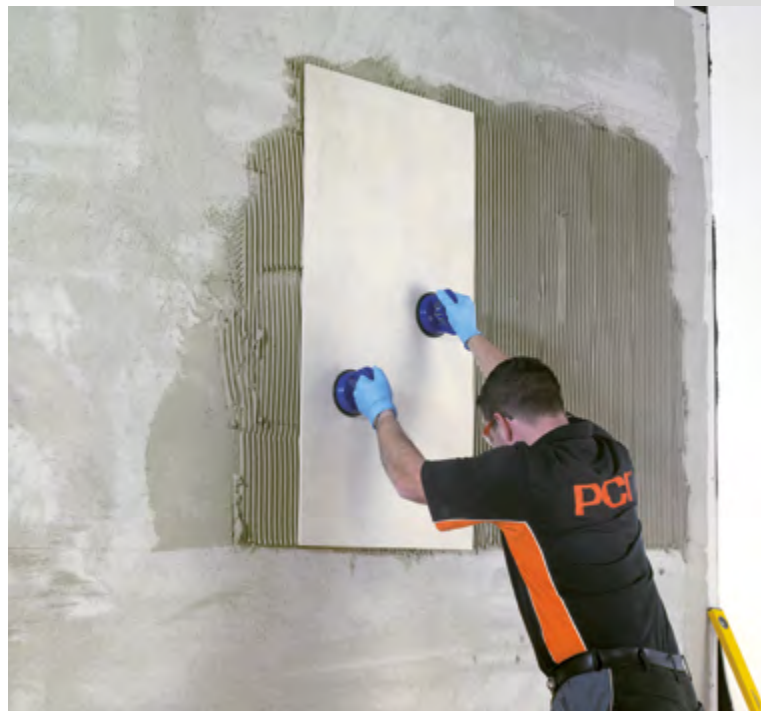
Fot. 4. Profesjonalne przysaski to nieodzowne narzędzie przy pracy z płytkami wielkoformatowymi
