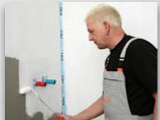
optyczna kontrola grubości powłoki
